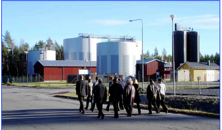
Norrmeyeriers biogasanläggning i Umeå.
